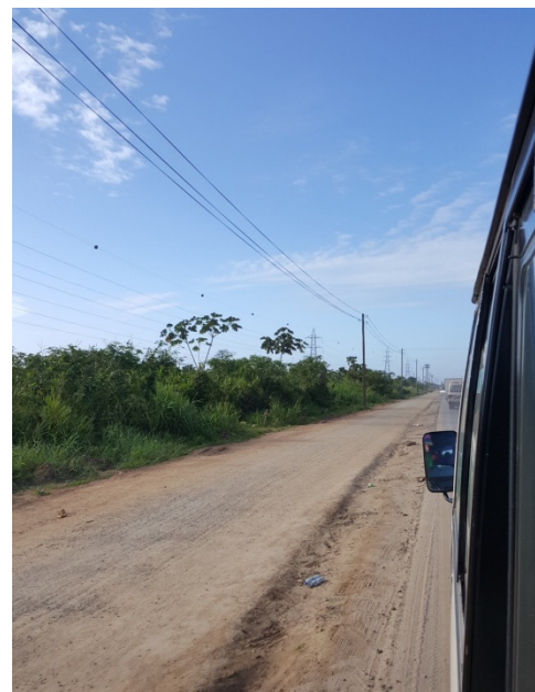
Abb. 13: Stromleitungen entlang der Straße zum Wasserkraftwerk (SAUERHAMMER 2019)
