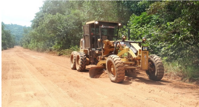
Abb. 4: Ausbaurbeiten auf der Linden- Lethem-Straße (BECKER 2019)
