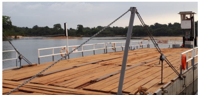
Abb. 5: Fähre auf der Linden- Lethem-Straße (BECKER 2019)
