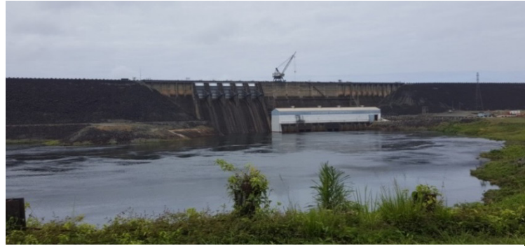
Abb. 11: Wasserkraftwerk Afobaka mit Staumauer (SAUERHAMMER 2019)
