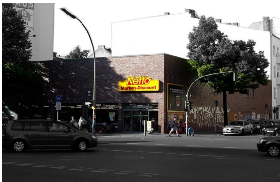
Abbildung 14: Discounter Blockbebauung saniert (Foto-Dokumentation LFP MQM 2018)
