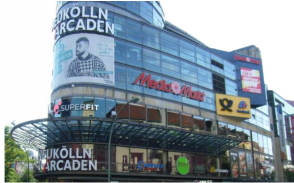
Abbildung 18: Shopping Mall Blockbebauung saniert (Foto-Dokumentation LFP MQM 2018)
