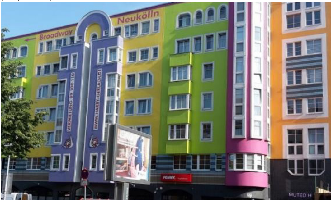
Abbildung 28: Bunte Fassadenwände im Gebiet Blockbebauung saniert (Foto-Dokumentation LFP MQM 2018)
