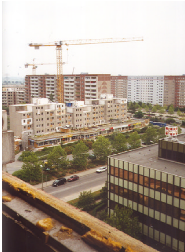
Abbildung 1: Rückbauprojekt „Ahrensfelder Terrassen“ in Berlin-Marzahn (2004)
