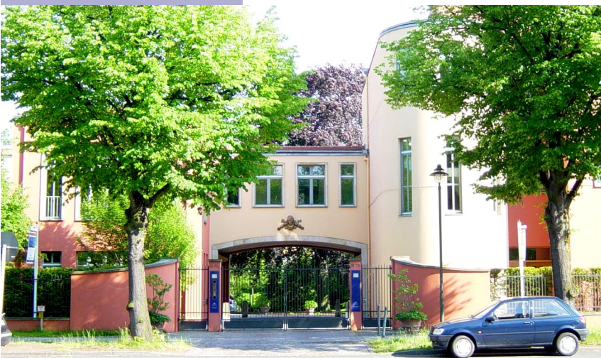
Abb. 9: Eingangsportale mit Doorman-Service zur Berliner Straße
